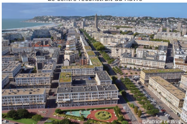
Le centre reconstruit du Havre
